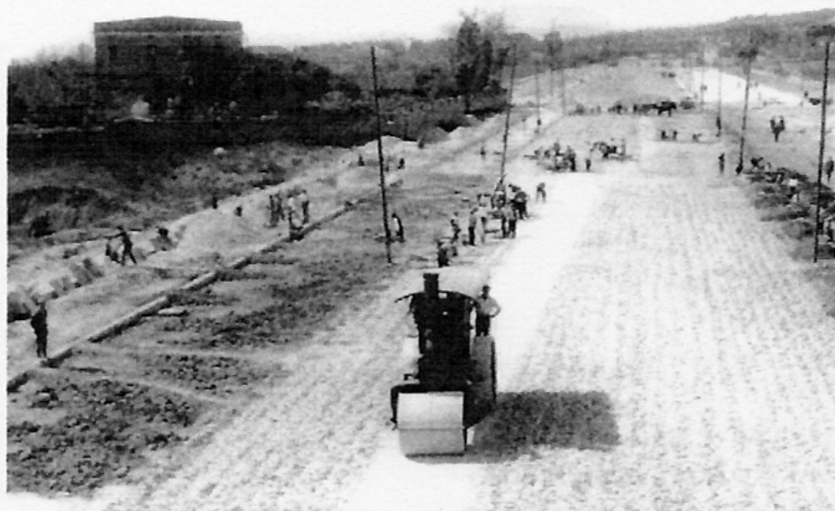
Les obres de perllongació de la Diagonal, una de les fotografies que il·lustren el llibre de Lluís Permanyer.
